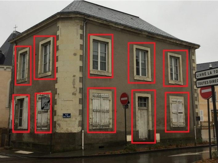
Façade Nord-Est + Façade Nord-Ouest
