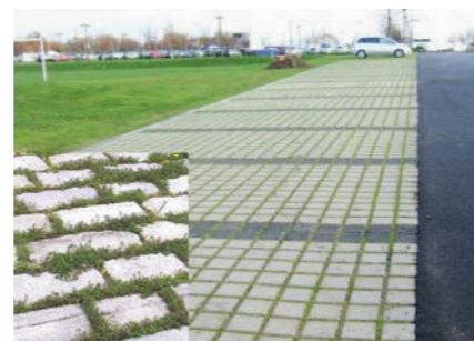
Stationnements en pavés béton à joints engazonnés
