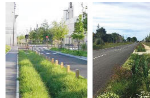
Noues de récupération des eaux pluviales plantées
